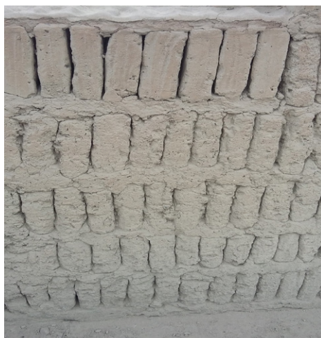
Figura 5. Distribución de adobes en muro. Nótese el acomodo tipo “librero”, en la parte superior se observan adobes contemporáneos usados en labores de restauración. Fuente: fotografía del trabajo de campo, 2020.
