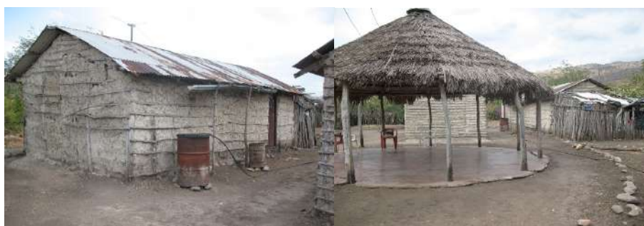
Figura 2. La casa de bahareque y la enramada de la casa de bahareque. 16
