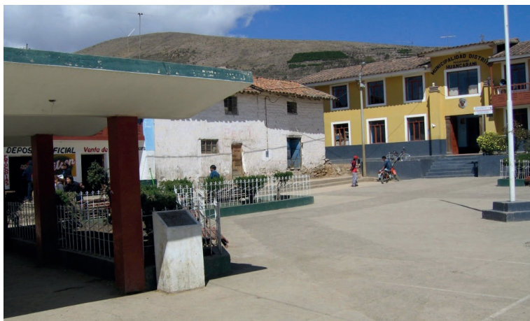
Figura 1. Un nuevo edificio municipal de concreto y la plaza de la ciudad pavimentada.
