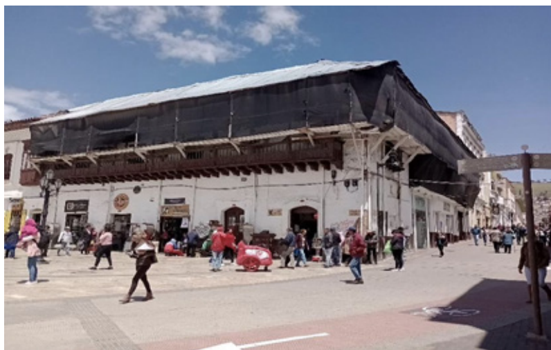
Figura 8. Elementos que protegen la fachada de la Casa de Diego de Oliva
