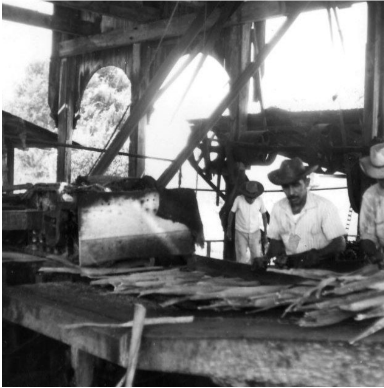
Figura 7. Vista interior de la planta desfibadora del henequén Cacalchén Cantón.
