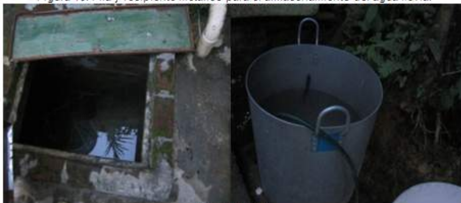
Figura 10. Pila y recipiente metálico para el almacenamiento del agua lluvia.
