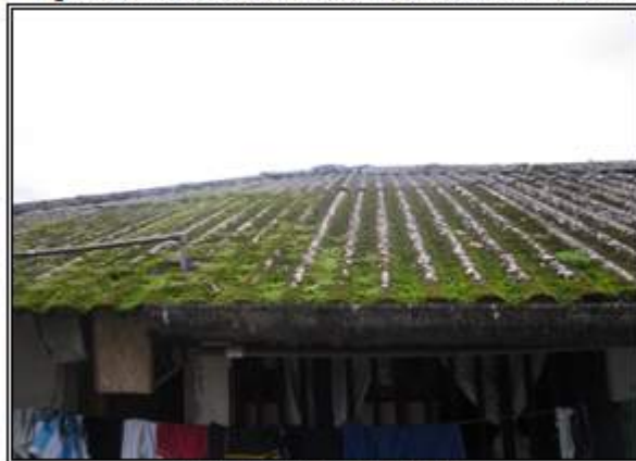
Figura 5. Techo en asbesto utilizado en las viviendas
