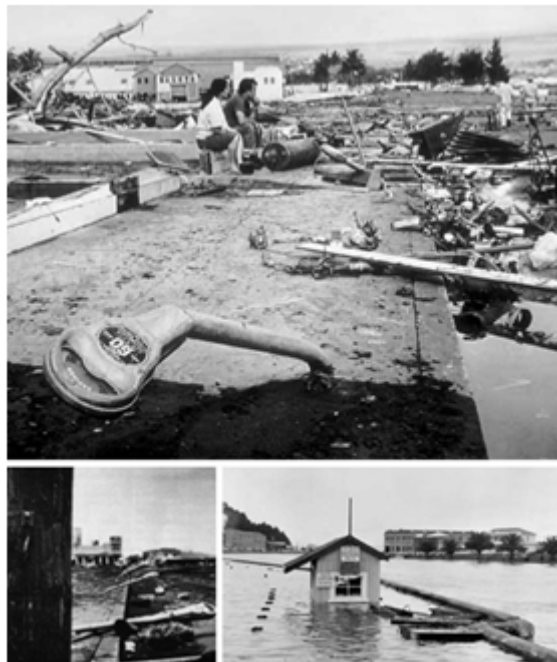
Figura 7. La imagen después de los desastres naturales causados por el agua.
