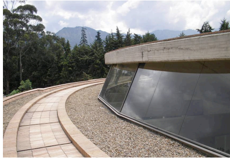
Fotografía 5. Relación edificio contexto, revelación del entorno.
