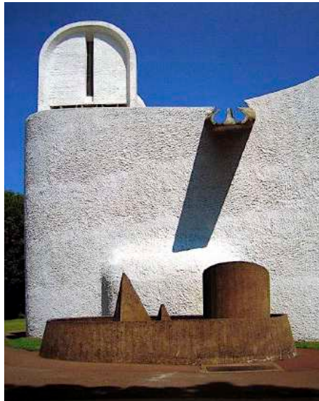
Figura 14. Gárgola y cisterna de la Capilla de Ronchamp. Fuente: foto del autor.
